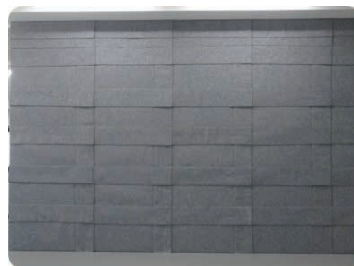
⑤施工完了
