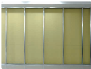
①LGSで下地を設置する
