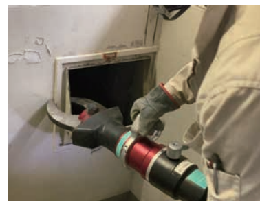
SD枠 解体風景
