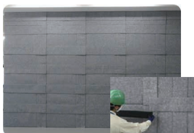
④パネルの継目に ジョイントテープを貼る
