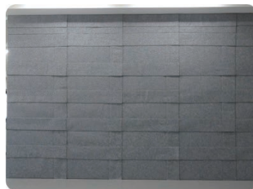
⑤施工完了
