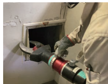
SD枠 解体風景
