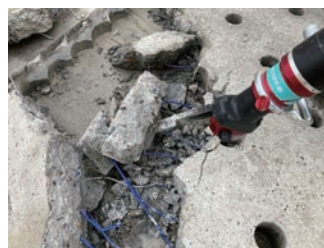
シンダーコンクリート 解体 ※サイシンダーと併用
