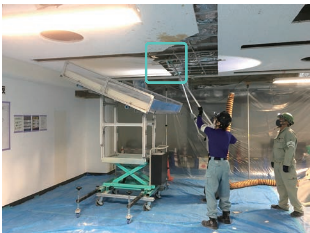
作業風景 ボードスライダーとセットで使うことで静かに解体が可能
