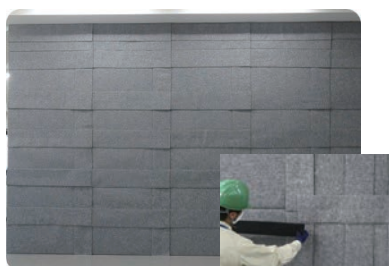
④パネルの継目に ジョイントテープを貼る
