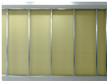
①LGSで下地を設置する
